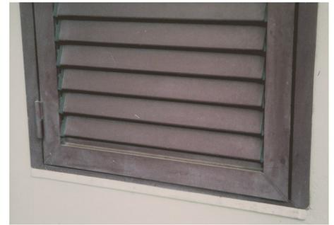
Abb. 1 - Detail eines eloxierten Fensterrahmens, der von Salzgehalt der Luft angegriffen wurde (Ostküste Sardinien).
