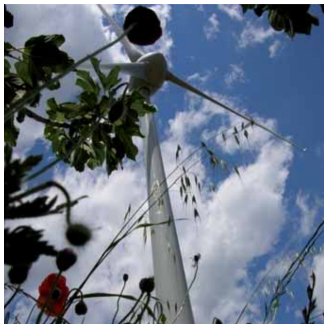
Impianto eolico a impatto zero
